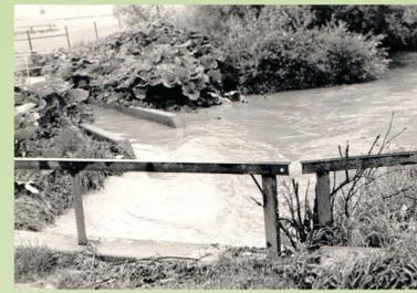
Der Urselbach an der Krebsmühle (mit Einlauf vom Klärwerk, links) staut sich an der Brücke. Der Rückstau bringt das Hochwasser.
